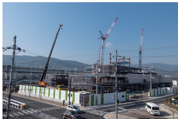
新病院建設状況 2021年1月14日撮影
